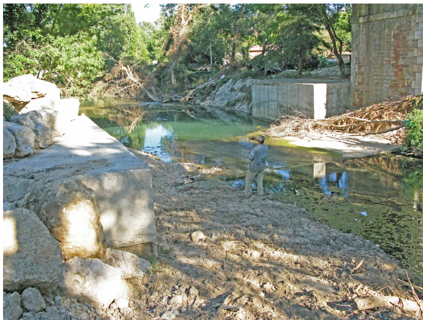
Photo 22 - Seuil et rétrécissement au pont de l'ancienne voie ferrée
