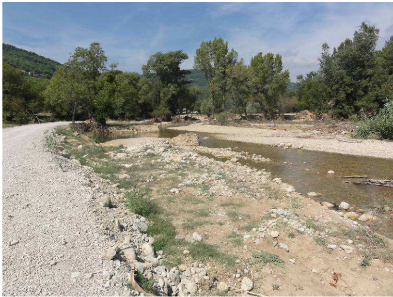
Photo 19 : Réduction de la capacité du lit en amont du seuil de la Clappe.
