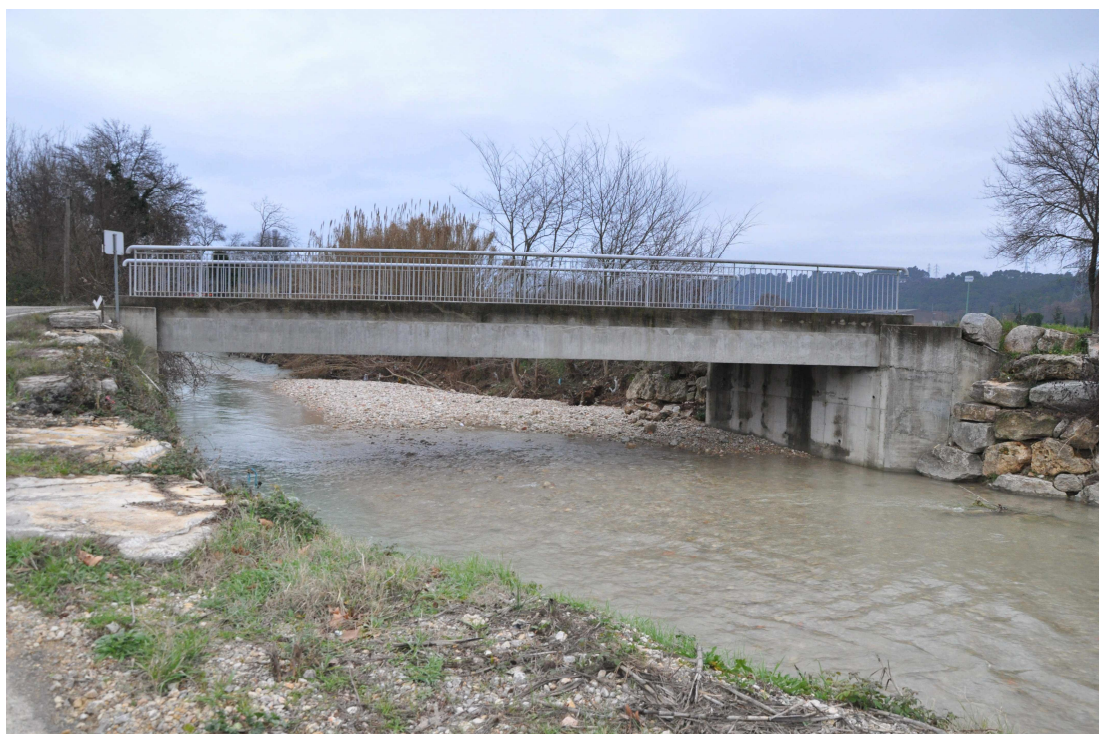
Photo 27 - Nouveau pont Bonhomme à Trans : l'abaissement des fonds consécutif à l'effacement du seuil de la Foux augmentera le tirant d'eau et la capacité d'écoulement, moyennant un contrôle de la stabilité des fondations.
