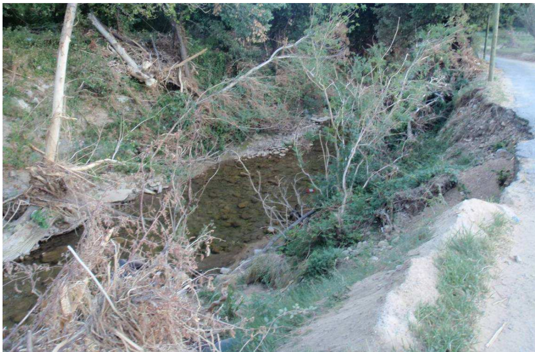
Photo 18 : Lit étroit en amont du pont d'Aups.
