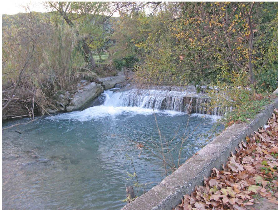
Photo 23 - Seuil de prise d'eau sur la Nartuby en aval du confluent avec la Foux
