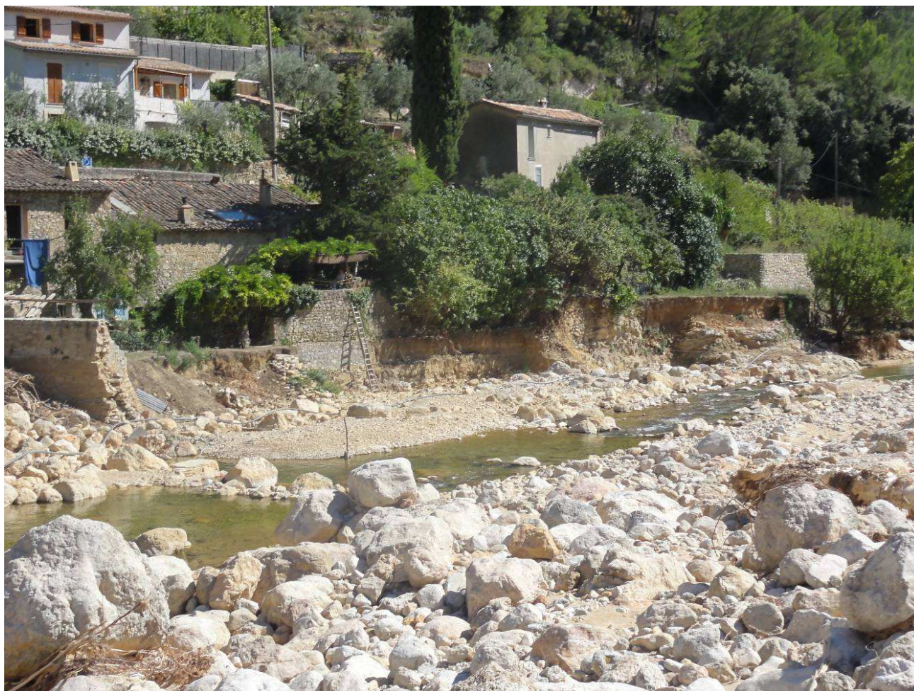
Photo 16 : Nouveau lit en rive gauche en amont de la station d'épuration.
