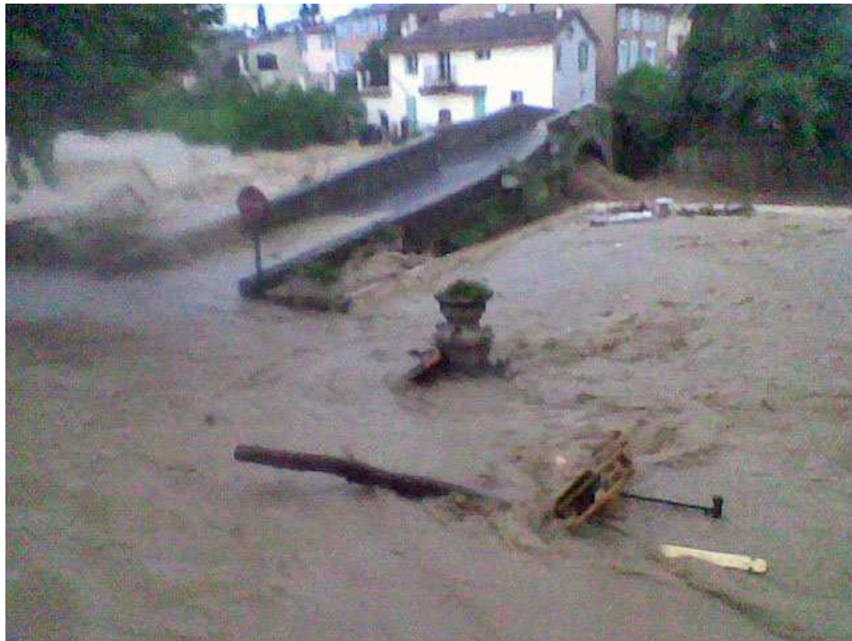
Photo 24 - Le Pont Vieux le 15-06-2010 à 23 heures : déversement sur le parapet amont en rive droite.
