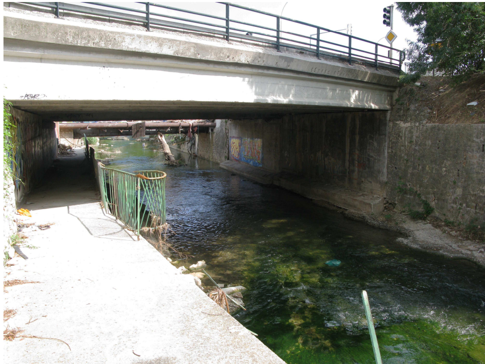
Photo 28 - Voie express à Trans : la passerelle Décathlon et le passage piétons
