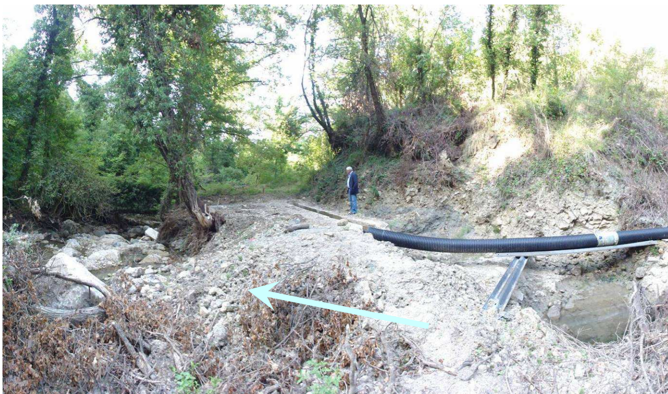
Photo 1 : Site du seuil de prise d'eau sur la Nartuby.
