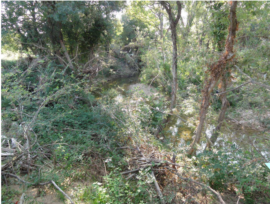
Photo 20 bis : Faible capacité du lit mineur.
