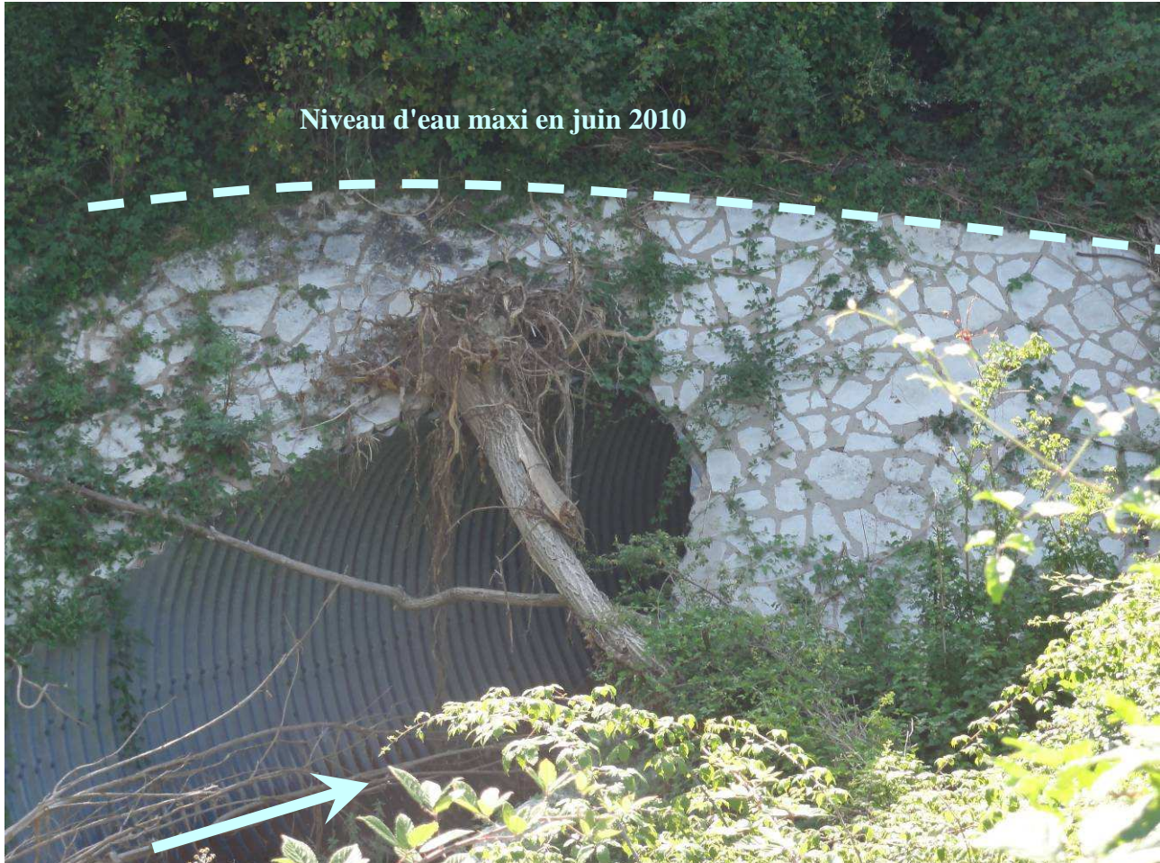
Photo 3 : Entrée de la buse du remblai de la RD 955.
