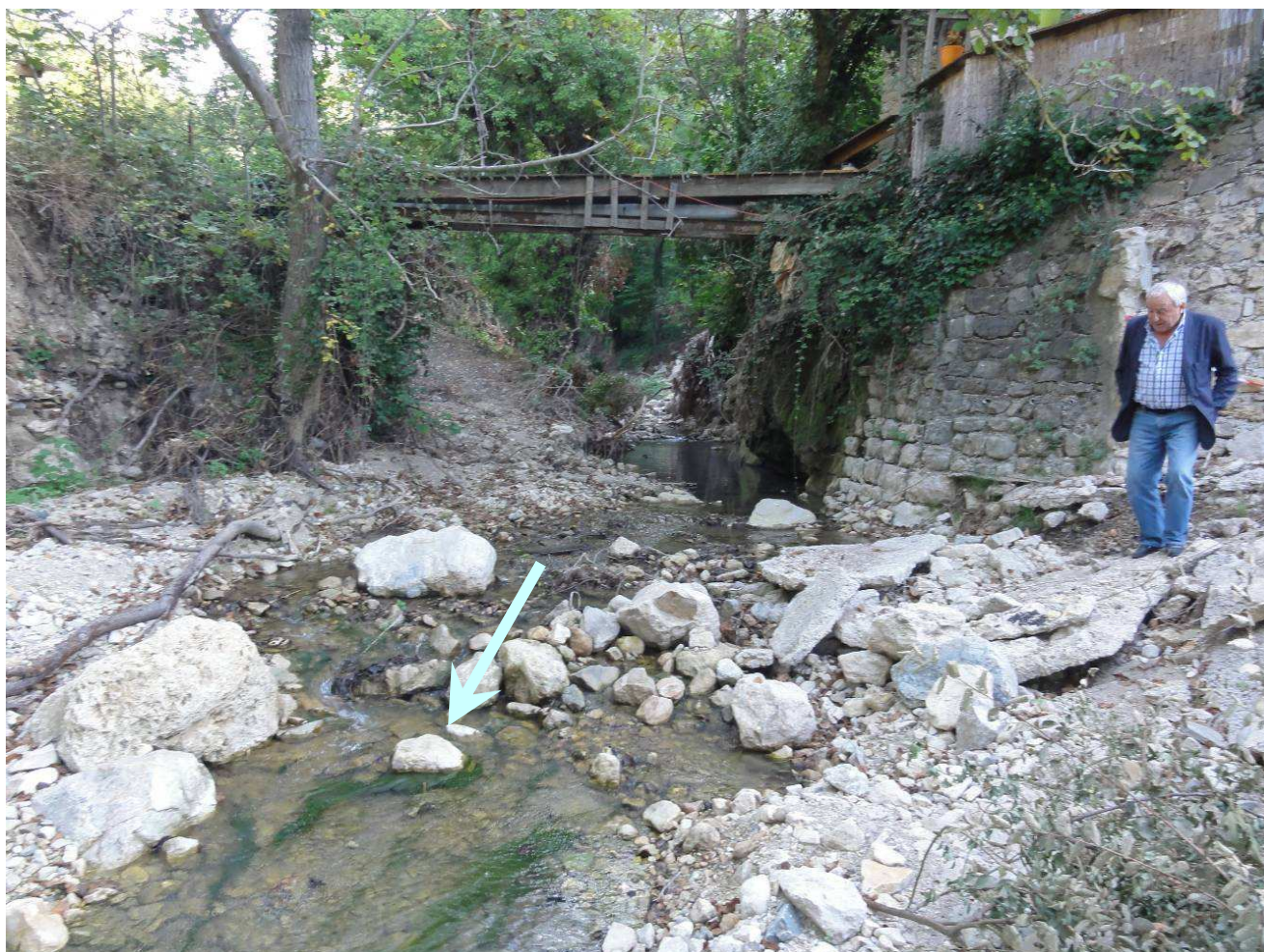
Photo 2 : Site du passage à gué vu de l'aval.
