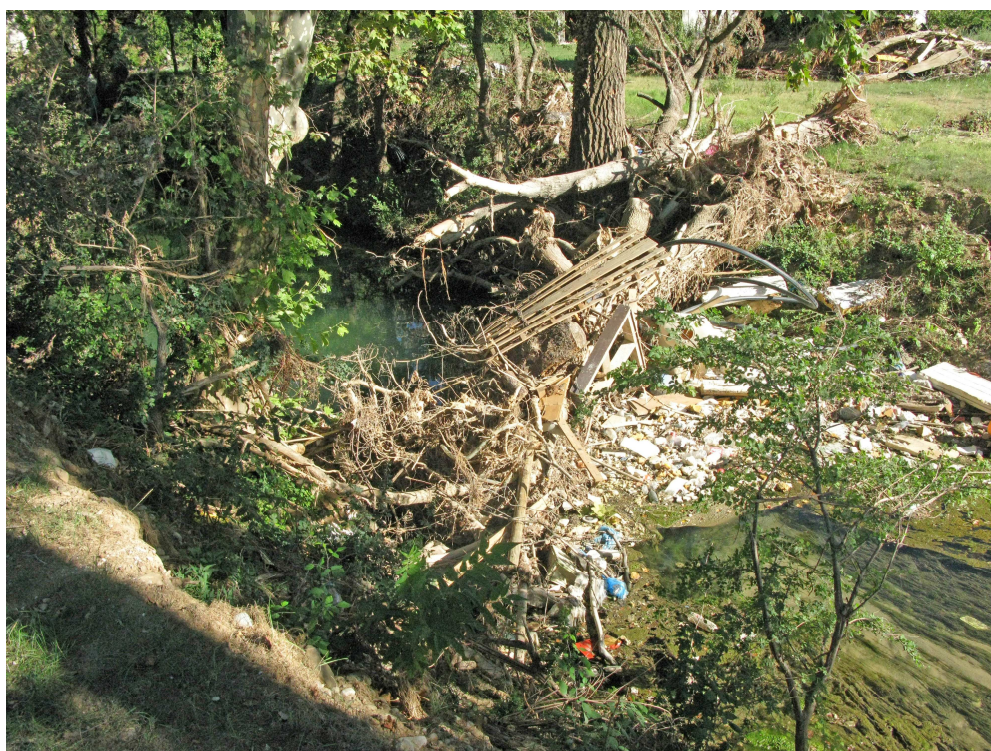
Photo 26 - 30 juin 2010 : embâcle barrant le lit de la Nartuby entre le pont des Incapis et le pont de l'ancienne voie ferrée
