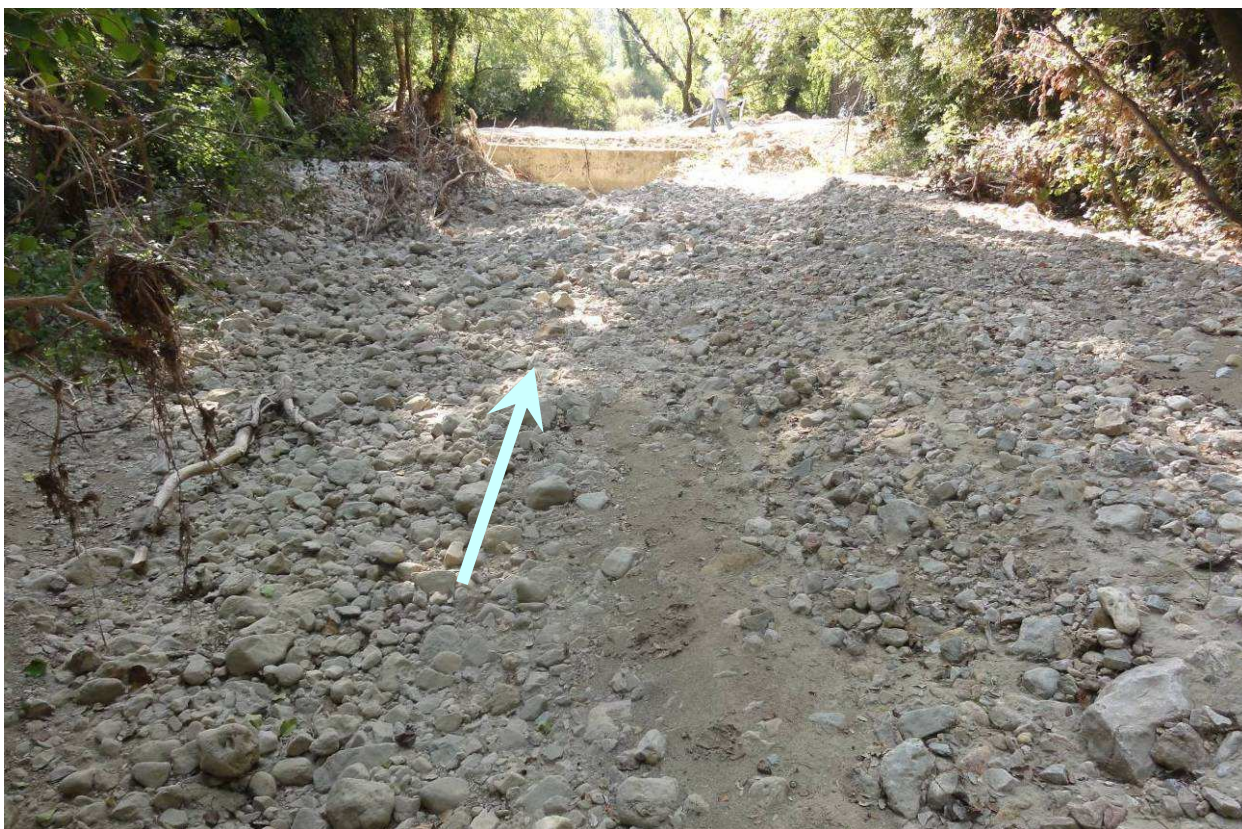
Photo 6 : Engravement du Bivosque en amont du passage à gué.
