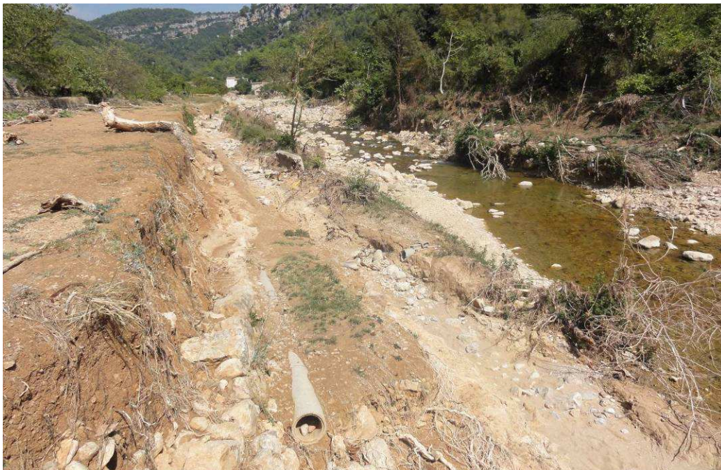
Photo 17 : Érosion des ouvrages en aval de Rebouillon.
