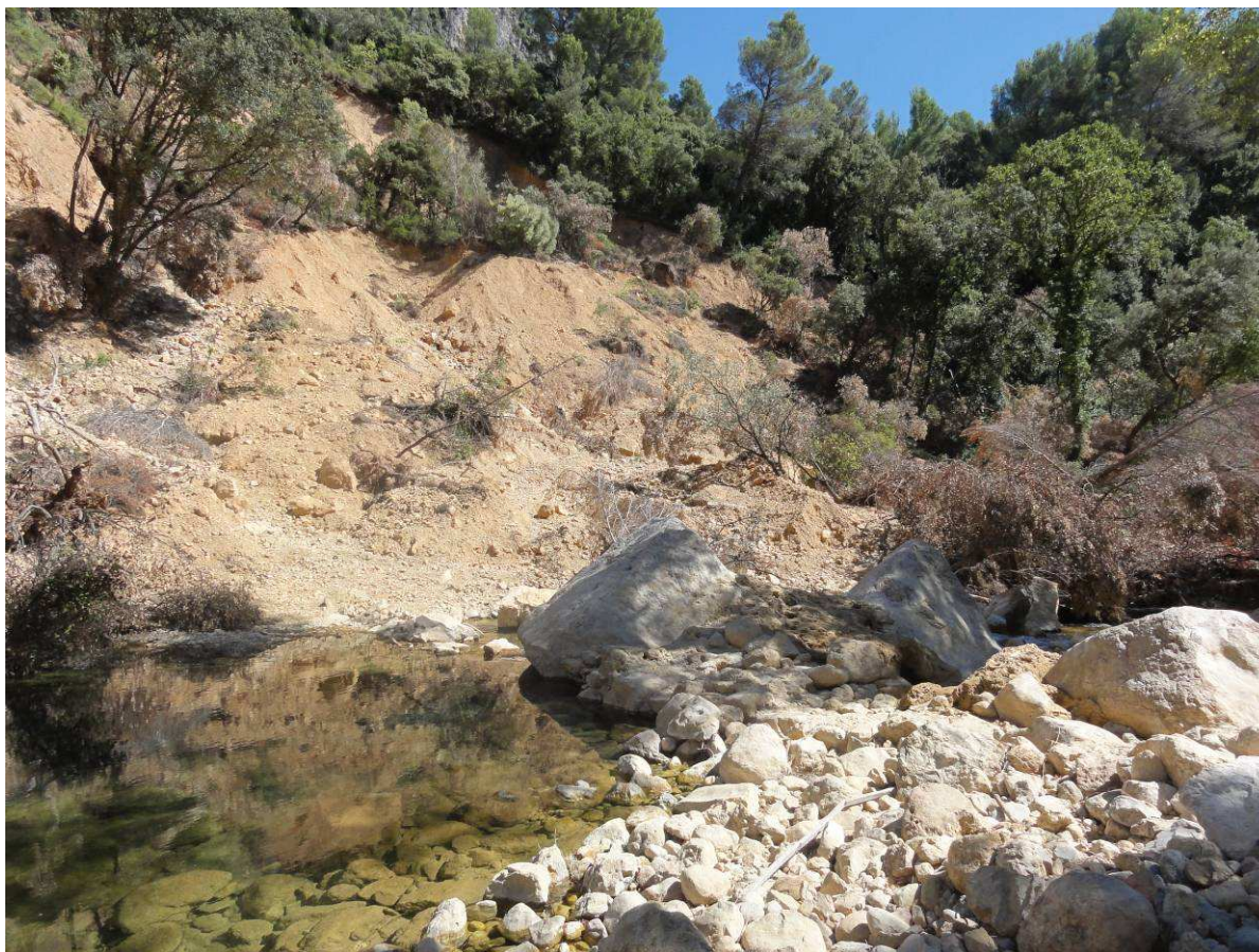
Photo 12 : Site de la prise d'eau vu de l'amont.
