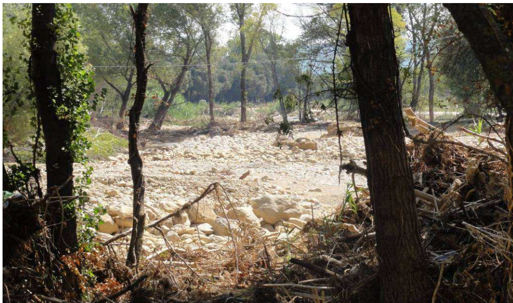
Photo 18 : Large divagation en amont du seuil de la Clappe.
