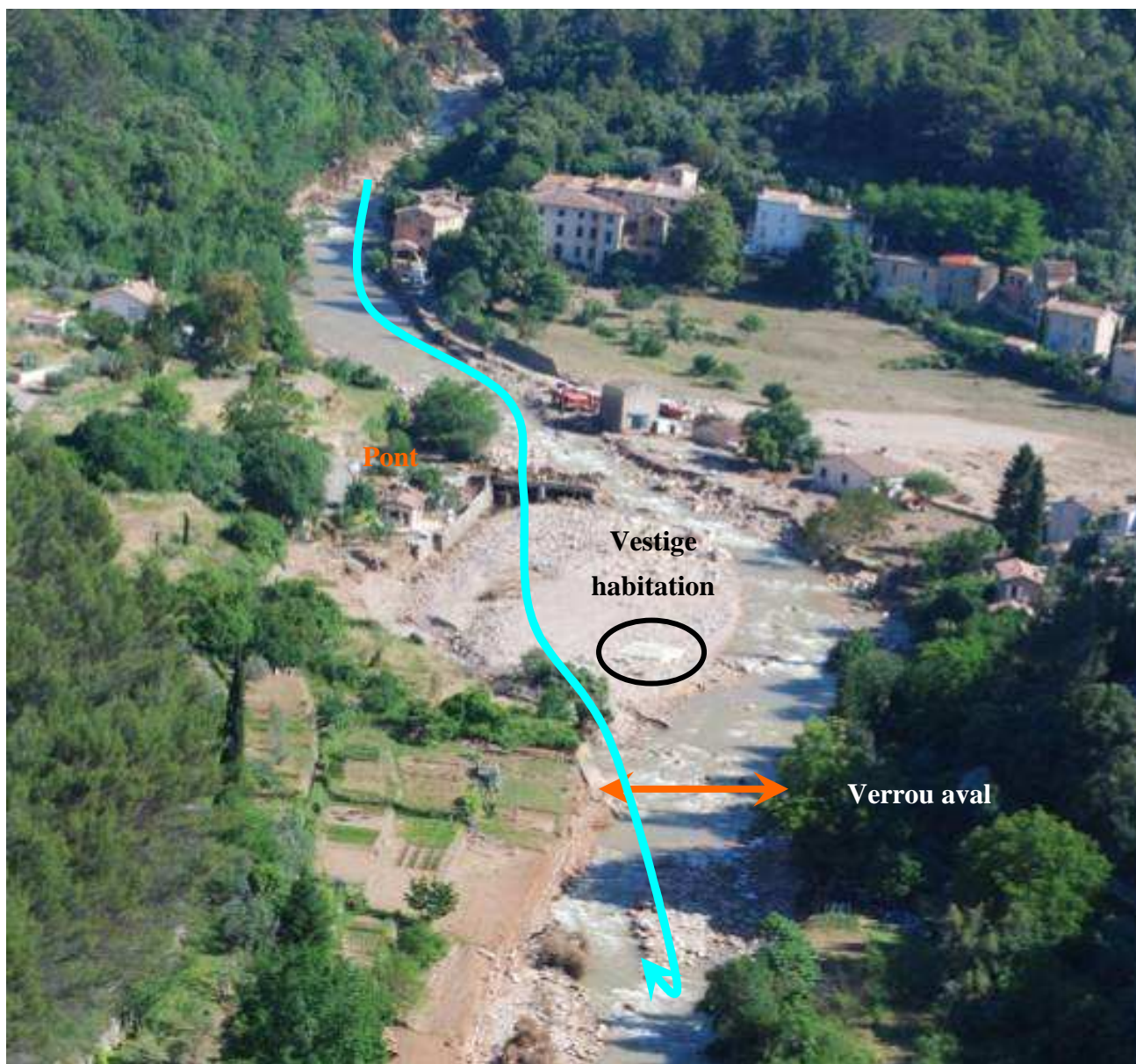
Photo 14 : Site de Rebouillon vu de l'aval.
