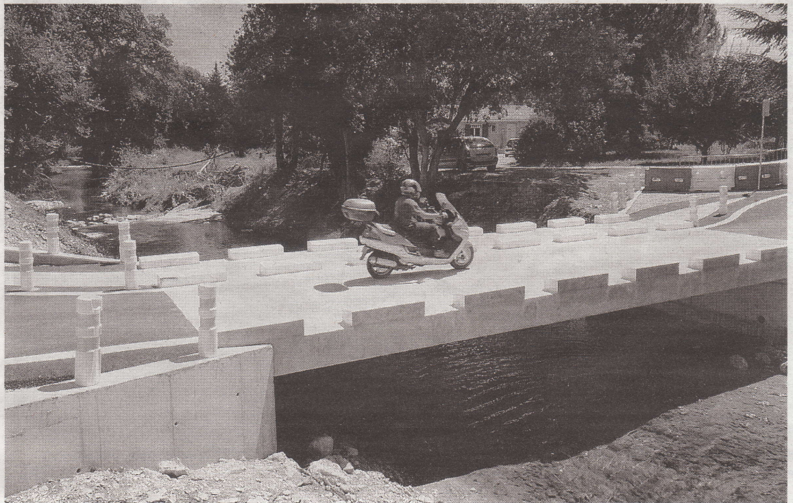
Pour remplacer le pont voûté des Incapis détruit par la crue, un pont submersible de 11 mètres temporaire a été reconstruit. Le rapport préconise pour sa part la réalisation d'un pont définitif doté d'un tablier de 25 m.
